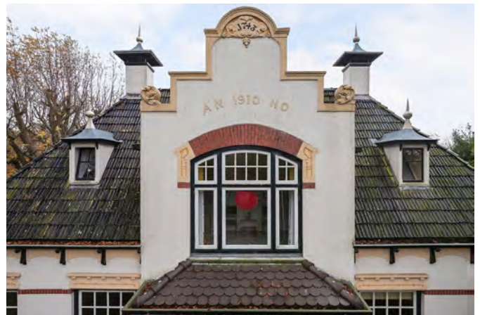
De nieuwe klokgevel uit 1910
