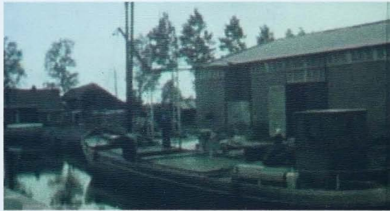
Kunstmestloods, gebouwd in 1953/54 door Kornelis de Vries.
