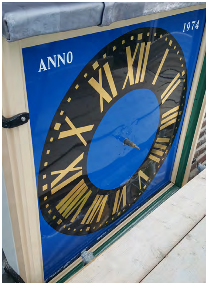
Wijzerplaat westzijde tijdens renovatie in 2021
