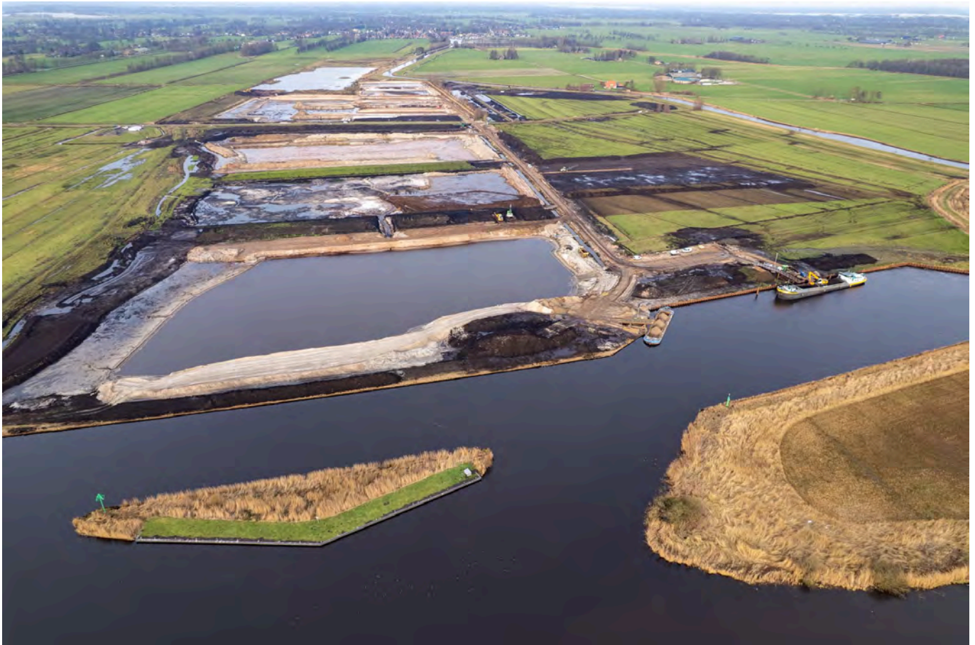
Het nieuwe meer de Nije Aldegeaster Sânnig in aanleg, drone Peter Veenema, januari 2026
