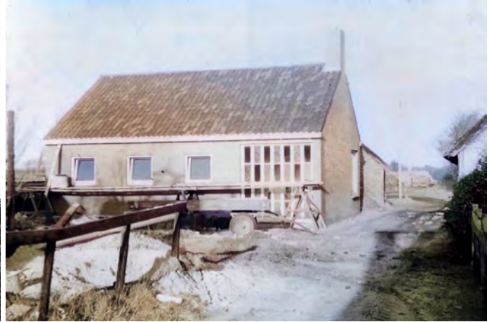
Foto van dia Arend Hovinga, 1962: Evangelisatiegebouw de Steech in aanbouw
