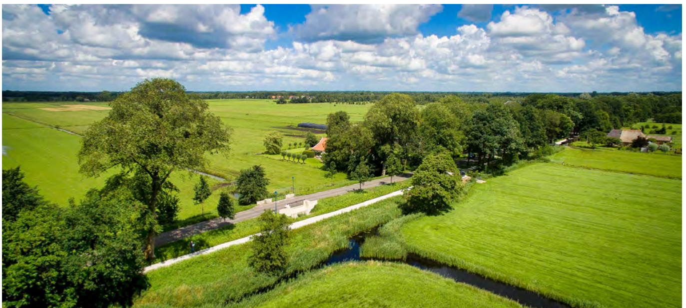
De brug in de Aldegeasterdyk, 2 juli 2016, drone Fred Kok
