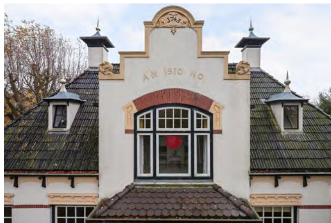
De nieuwe klokgevel uit 1910
